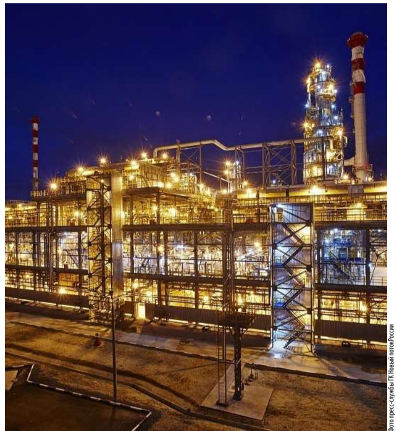
Фото пресс-службы ГК «Новый Поток»
